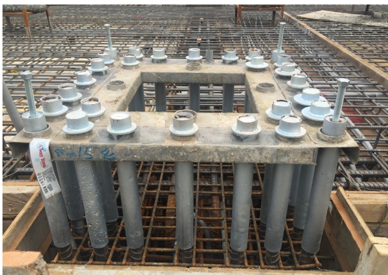
圖 R9.4 接合用鋼筋之定位板照片
