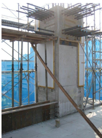
(2)實際梁柱接頭施工圖
