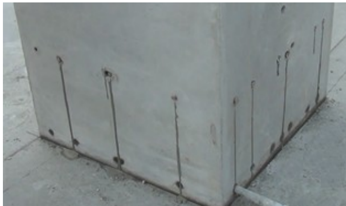
圖 R8.13 預鑄柱續接套筒與柱底接縫同時灌注填充料之照片
